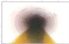
工事完成後の下水道管の内部
