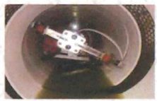
樹脂製の新しい内壁を形成
